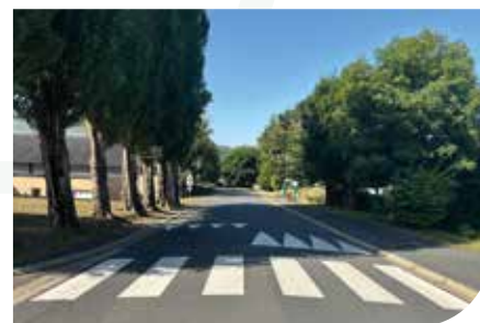
Peinture routière effectuée cet été
